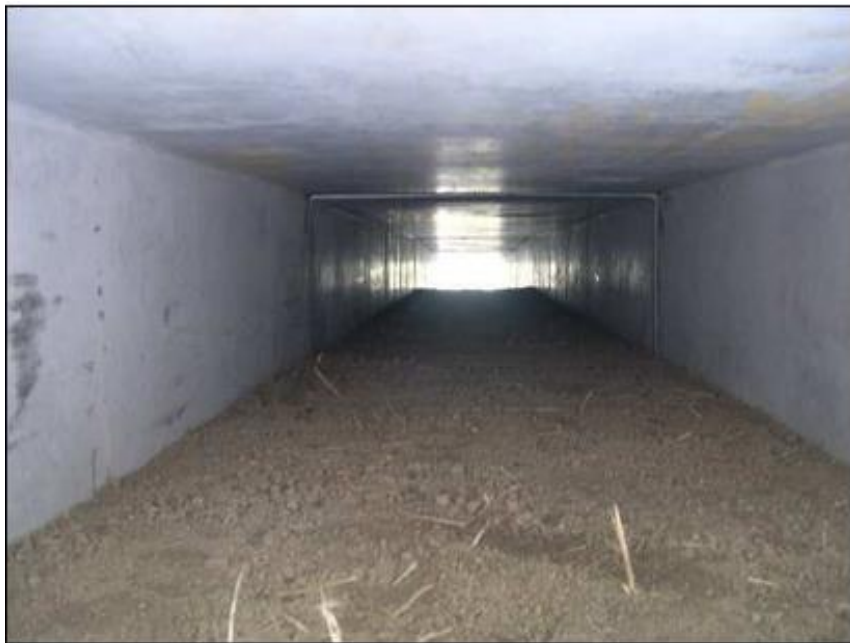
Foto 21. Tunneli põhi peab olema pinnasega kaetud (foto L. Briggs).
