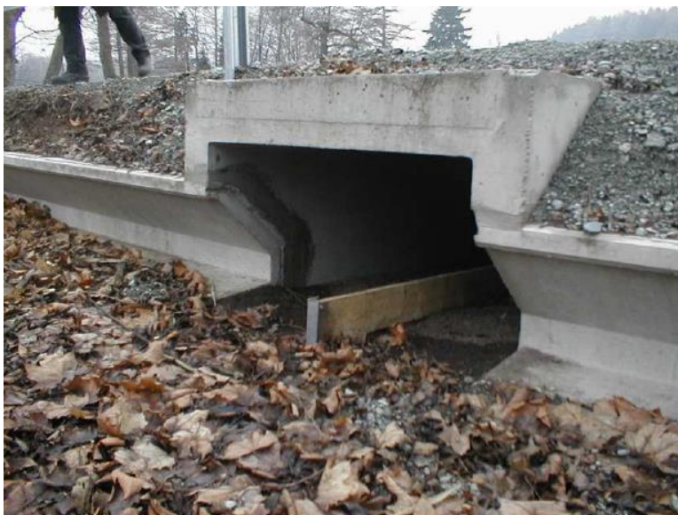
Foto 20. Kahepaiksetele on sobivaim betoonist tunnel mis on kombineeritud betoonist konnataraga. Laud tunneli suudmes takistab loomade tee ja suunab nad tunnelisse (foto L. Briggs).
