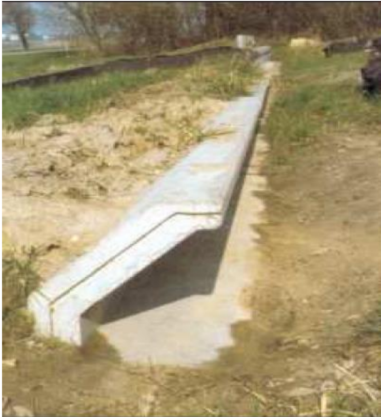
Foto 19. Kahepaiksetele on sobivaim betoonist piire, mis on ilmastikukindel, ei paindu ega purune ning kestab hoolduseta aastakümneid (foto L. Briggs).
